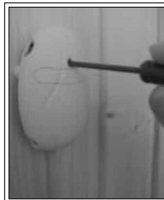
9. ábra: A túlmelegedés-korlátozó Visszaállítás gombja
